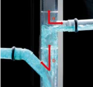
Bild 2: Anschluss der Falleitung... a – richtig b – falsch
