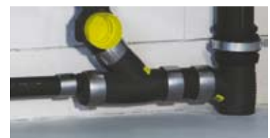
Bild 7: Richtige Anordnung des Übergangsstückes.
