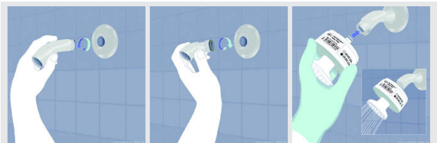
Einbau eines Sterilwasserfilters am Beispiel einer Kopfbrause: Die vorhandene Kopfbrause wird entfernt, das spezielle Adapterstück montiert. Der Sterilwasserfilter wird daran per Schnellkupplung montiert bzw. nach seiner zugelassenen Standzeit demontiert (ausgewechselt).
