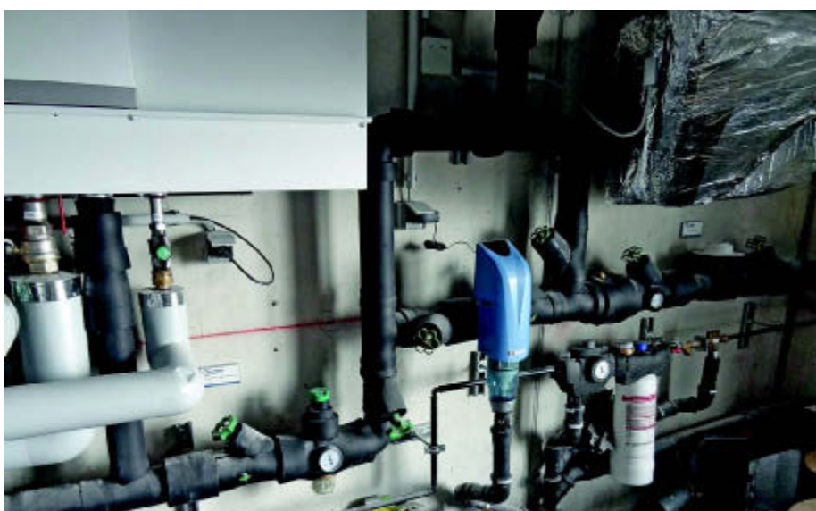
Gedämmte Trinkwasserleitung kalt in einem Technikraum.
