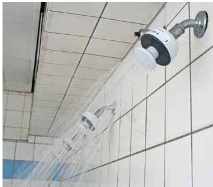
Die Standzeit dieser endständigen Filter beträgt bis zu 31 Tage.
