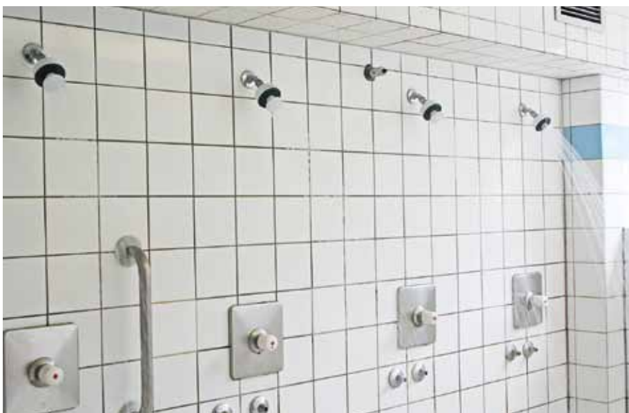
Mit endständigen Wassersterilfiltern ausgestattete Duschenanlage.
