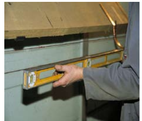
Überprüfen des Rinnengefälles mit einer Wasserwaage.
