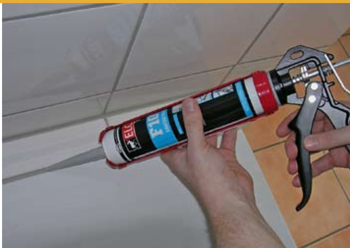
■ Mit der Handpresspistole wird der Dichtstoff aus der Kartusche fachgerecht in die Fuge gespritzt.
