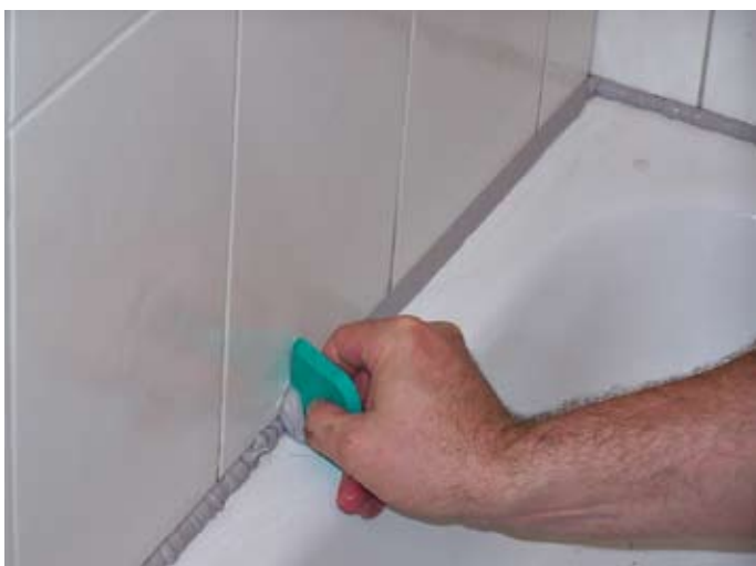
■ Überschüssiges Material wird mit einem Glättwerkzeug entfernt und die Fuge dann in die gewünschte Form gebracht.
