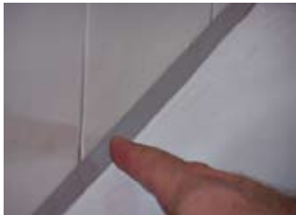
■ Etwaige Unebenheiten lassen sich mit dem Finger und einem Glättmittel leicht ausgleichen.
