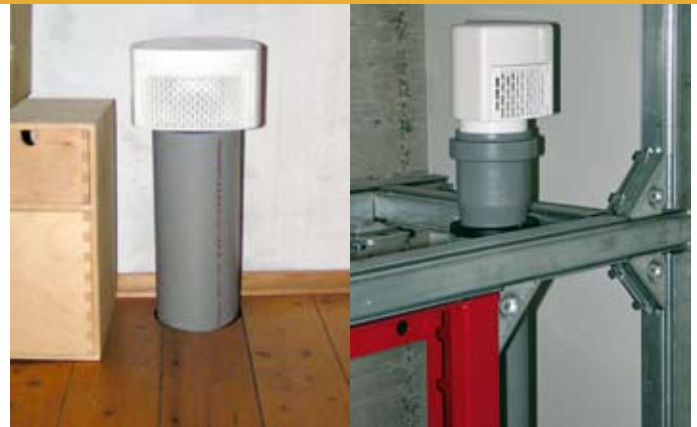
■ Zwei von vielen möglichen Einbauorten: Auf einem Dachboden (links) und in einer Vorwandinstallation.
