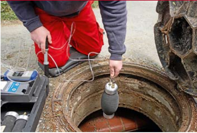
■ Druckprüfung mit Luft: Die Abdichtblase wird zunächst eingebracht...
