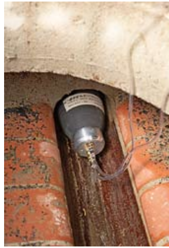
■... und mit einer Schubstange bis zur gewünschten Position in das Abwasserrohr geschoben. Nach Abdichtung des Leitungsabschnittes kann die Druckprüfung erfolgen.
