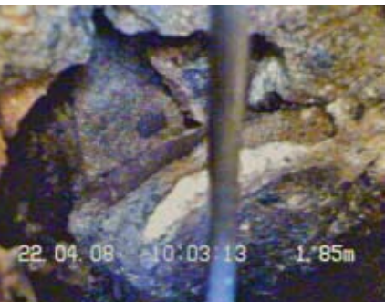
■ Aufgeplatzter Abwasserkanal.
