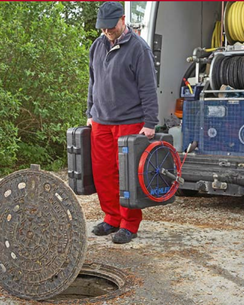
■ Bevor es so richtig losgeht, muss die Baustelle eingerichtet und abgesichert werden.
