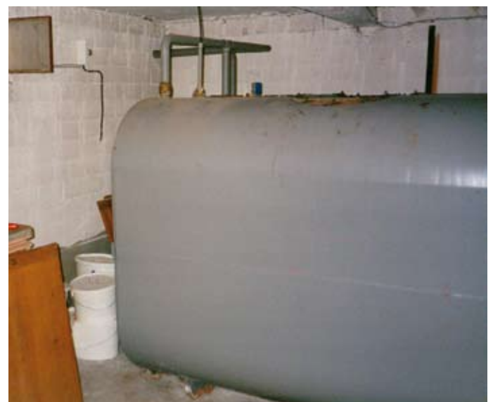
■ Bild 3: Der „Reservefallschirm“ Auffangraum hat hier seine Funktion eindeutig verfehlt. Bild: IWO
