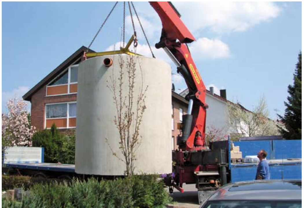
■ Lieferung und Versetzen des Fertigteil-Pelletspeichers mit 8 m 3 Fassungsvermögen.
