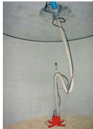
■ Das Entnahmesystem „Maulwurf“, am Federzug von oben gehalten, bewegt sich langsam über den Pelletvorrat; vom Speicherinnenraum aus gesehen.
