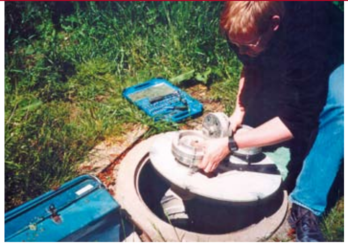
■ Einsetzen der Stahlplatte mit Einfüll- und Absaugstutzen in den Speicherkonus.
