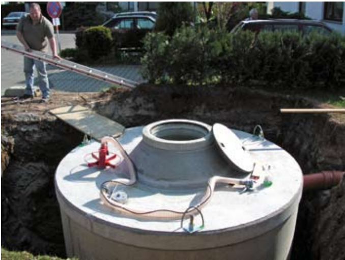
■ Abdeckplatte und Konus sind montiert, das Entnahmesystem „Maulwurf“ wird eingesetzt.
