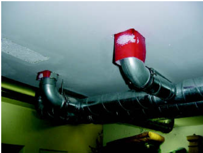
■ Bild 8: Bei diesem Beispiel sind zur schalltechnischen Entkopplung alle Rohre im verbauten Bereich mit einem PE-Schlauch versehen. Die Dämmung der Kanäle sowie brandschutztechnische Maßnahmen sind noch nicht realisiert worden.
