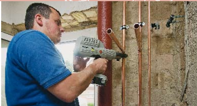
■ Pressverbindungstechnik bei sämtlichen Rohrinstallationsarbeiten war für die Büring-Fachhandwerker ein Muss, denn anders hätte sich der enge Zeitrahmen keinesfalls einhalten lassen.
