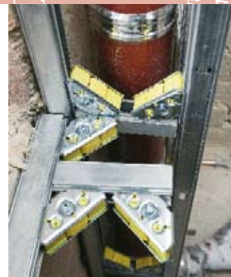
■ Dank der erst auf der Baustelle abgelängten Schienen des Steptec-Vorwandsystems lässt sich jeder Zentimeter Raum nutzen. Gerade bei Arbeiten im Bestand, wo die Bäder nicht beliebig zu vergrößern sind, ist das ein entscheidender Vorteil.
