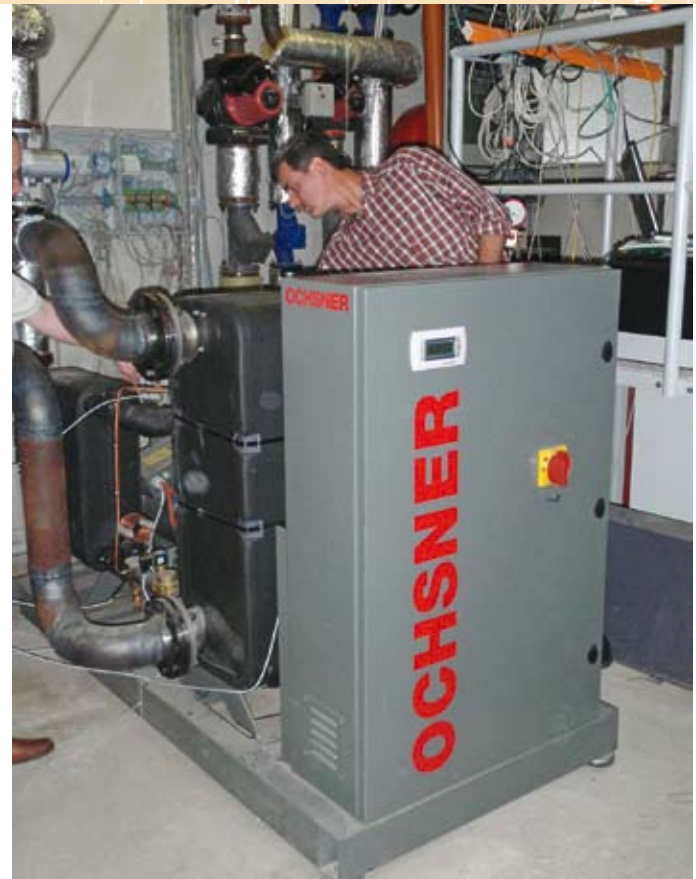
■ Serienmäßige Wärmepumpen von 80 bis 960 kW Heizleistung, bei 65°C Vorlauftemperatur bietet der österreichische Hersteller Ochsner an. Bild: Ochsner Wärmepumpen GmbH, Linz (Österreich)
