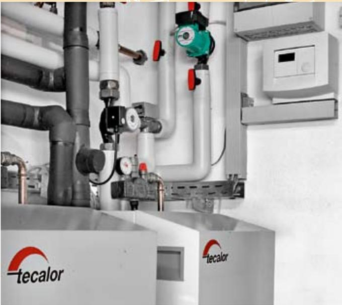
■ Zwei Tecalor-Wärmepumpen vom Typ „TTW 44 SET“ ermöglichen die Beheizung und Kühlung eines Gewerbebetriebes. Da im Sommer das Grundwasser nicht über 12 °C ansteigt, kann es zusätzlich über einen Wärmetauscher für eine passive Kühlung genutzt werden. Sie wird ebenso wie die Wärme über Strahlungsplatten abgegeben.
