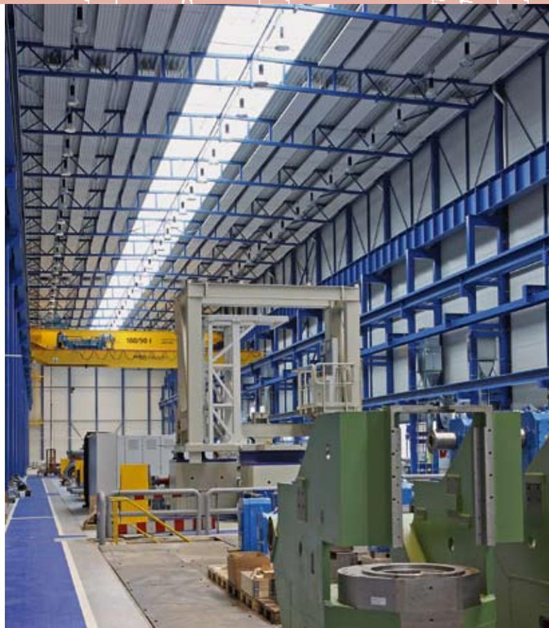
■ Rund 1,8 km lang sind die Deckenstrahlplatten in der Schwerlasthalle, die für Wärme bzw. im Sommer für Abkühlung sorgen. Bild: PNR
