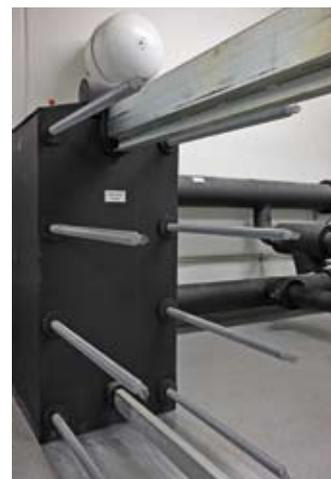
■ Der Wärmetauscher, der für eine mögliche Erweiterung vorbereitet ist, bietet den Übergang vom Grundwasser-Kreislauf auf den Wasser-Glykol-Kreislauf der Wärmepumpen.
