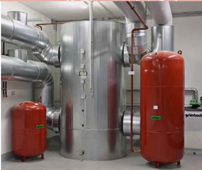
■ Der Pufferspeicher vermeidet eine zu schnelle Taktung der Wärmepumpen und sorgt so für einen effizienteren Betrieb. Bild: PNR
