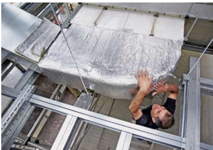
■ Um die Dämmung den erforderlichen Radien der Bögen anzupassen, wird mit dem Messer die Alu-kaschierte Matte eingeschnitten und anschließend verklebt.
