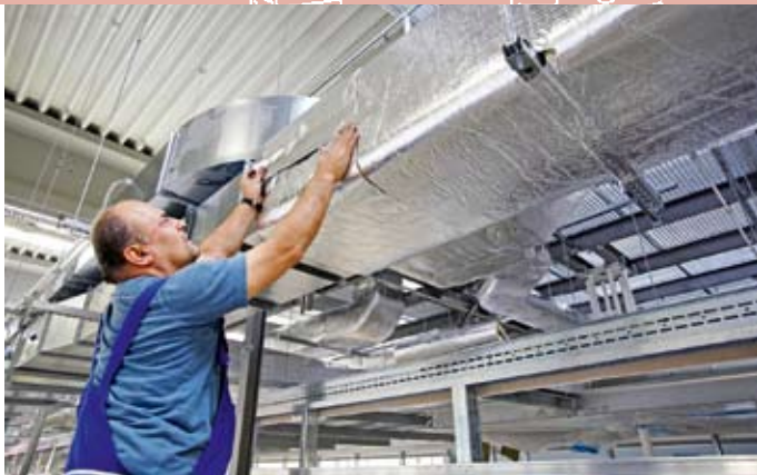
■ Alukaschierte Steinwolleplatten sorgen für spürbare Energieeinsparung in der Luftverteilung. Die „Klimarock“-Platten lassen sich mit einem Aluklebeband fixieren.
