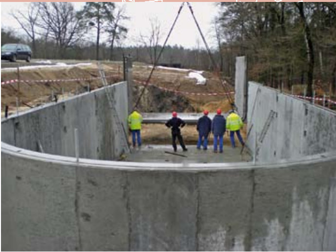
■ Montage der Zisterne aus Stahlbeton-Fertigteilen. Innerhalb eines Tages konnten die U-förmigen Segmente, einschließlich der Abdeckplatten und Einstiegsöffnungen, mit den zylindrischen Endstücken verschraubt werden.
