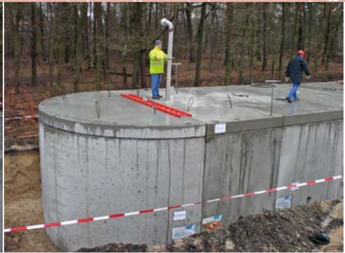
■ Montage der Zisterne aus Stahlbeton-Fertigteilen. Innerhalb eines Tages konnten die U-förmigen Segmente, einschließlich der Abdeckplatten und Einstiegsöffnungen, mit den zylindrischen Endstücken verschraubt werden.
