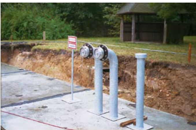
Innerhalb eines Tages konnten die U-förmigen Segmente, einschließlich der Abdeckplatten und Einstiegsöffnungen, mit den zylindrischen Endstücken verschraubt werden. Innerhalb eines Tages konnten so die U-förmigen Seg-
