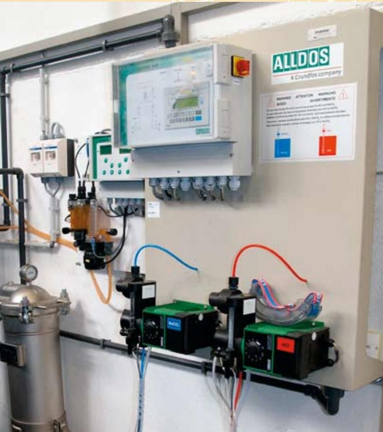
■ Desinfektionsverfahren auf dem Prüfstand. Nach dreimonatiger Chlordioxid-Dosierung waren in den Warmwasserleitungen des Krankenhauses keine Legionellen mehr nachweisbar.
