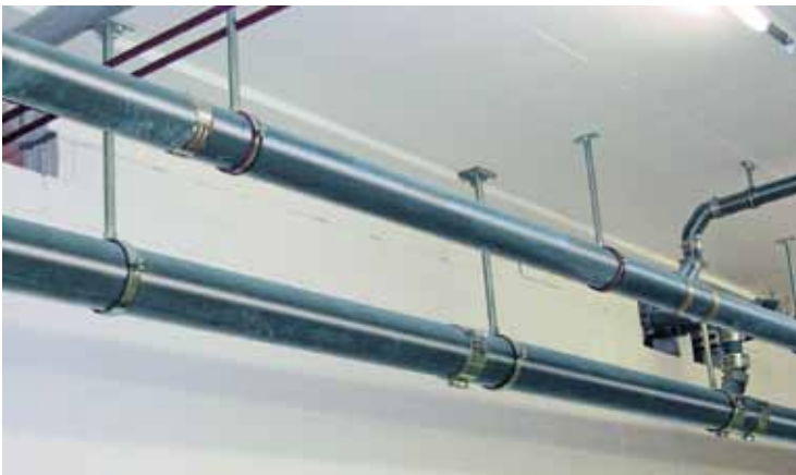
Beispiel eines Bauprodukts der Brandklasse A1: „MLK-protec“ mit Sonderbeschichtung von Düker. Bild: Düker GmbH & Co. KGaA
