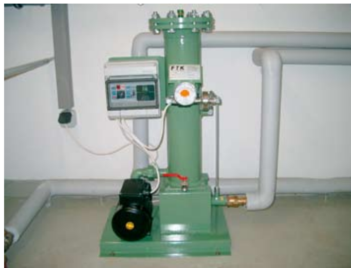
■ Die Feinstfilteranlagen von FTK sind für den dauerhaften Betrieb innerhalb großer Heizungsanlagen ausgelegt. Modelle mit vier Filterkerzen und für Heizungsanlagen größer 1000 kW Heizleistung sind erhältlich. Daneben gibt es auch mobile Lösungen zur Reinigung von Kleinstanlagen.
