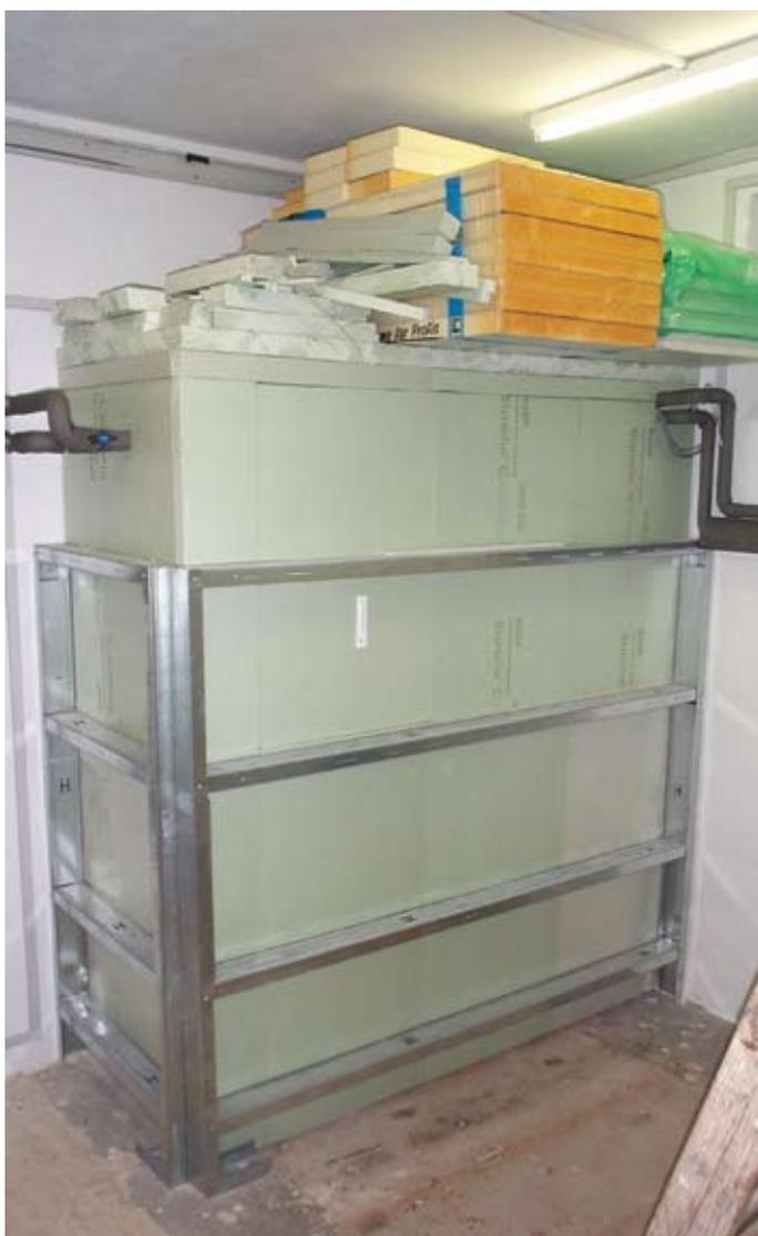
■ Mit einer Dämmschüttung zwischen den einzelnen Röhren werden die Paraffin-Latentwärmzellen von Powertank isoliert. Bild: Powertank
