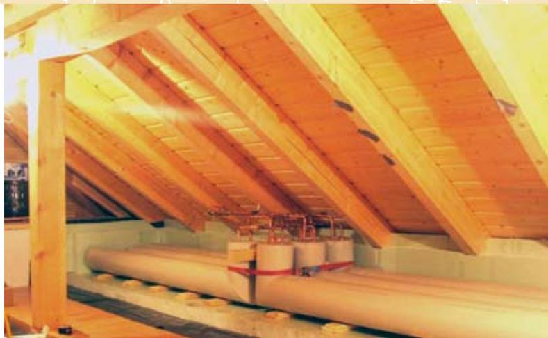
■ Liegend angeordnete Latentwärmезellen der Firma Powertank beim Einsatz der Pufferung von Solarenergie. Eine Lösung mit geringem Platzbedarf.
