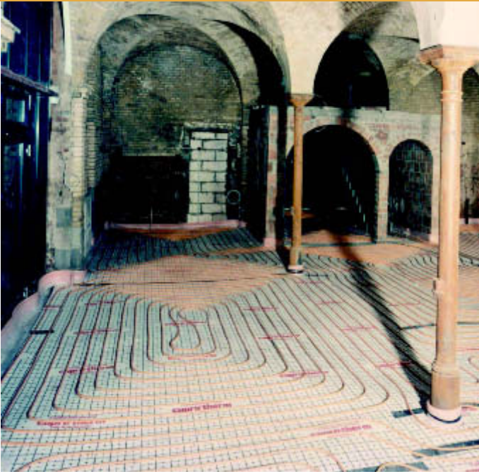
■ Konventionelle Fußbodenheizungen wie das Cuprotherm-System können in Sanierungsobjekten dann eingesetzt werden, wenn die verfügbare Aufbauhöhe und die Statik dies zulassen. Bild: Wieland-Werke
