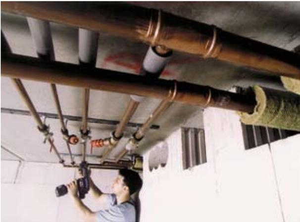
**Unproblematisch: „Mischinstallation“ aus „Sanco“-Kupferrohr und Absperrventilen aus Messing.**
