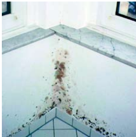
■ Bild 5: Schimmelpilze in Wohnungen sind ein verbreitetes Problem.
