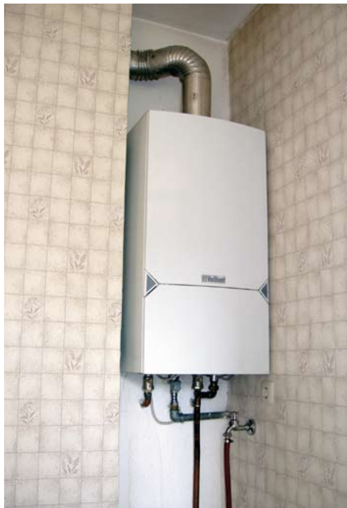
■ Bild 1: Wohnungen mit raumluftabhängigen Gasetagenheizungen sind statistisch signifikant deutlich seltener von „Schimmelpilzbefall“ betroffen als gebäudezentral beheizte Wohnungen.
