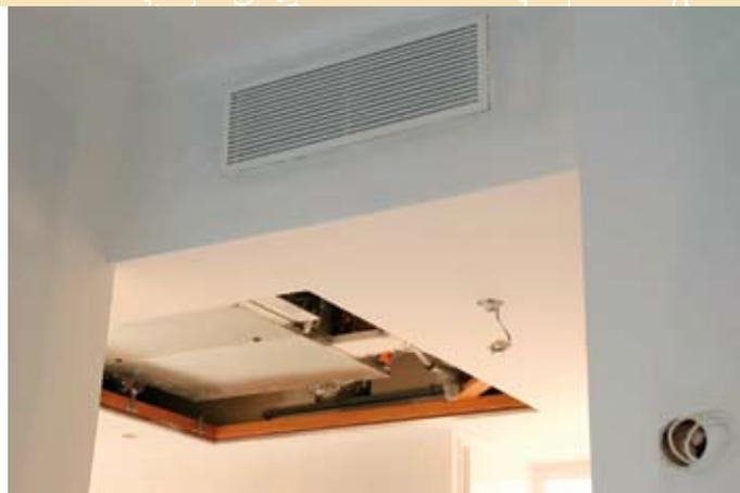
■ Fan-coil sowie Zu- und Abluftkomponenten werden in der Zwischendecke im Flur „unsichtbar“ montiert.
