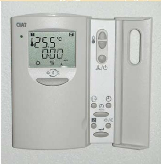
■ Die Einzelraumregler werden über eine Bus-Leitung mit dem Zentralgerät verbunden.
