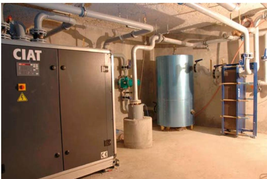
■ Technikzentrale mit Kalt- und Warmwassererzeuger für ein Appartementgebäude.
