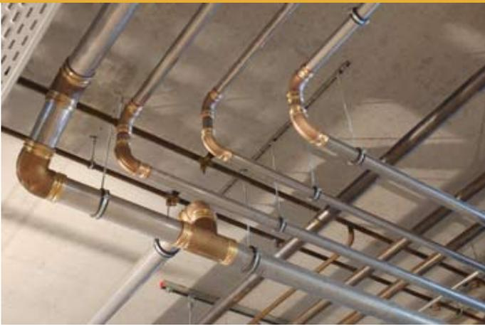
■ Bild 1: Trinkwasserinstallation aus ferritischem Stahl 1.4521, hier in Kombination mit Rotgussfittings. Diese Edelstahlqualität ist im Hinblick auf den Einsatz in der Trinkwasser-Installation dem molybdänhaltigen austenitischen Stählen 1.4401/1.4404 durchaus ebenbürtig. Äußerlich sind die Stahlsorten nicht zu unterscheiden.
