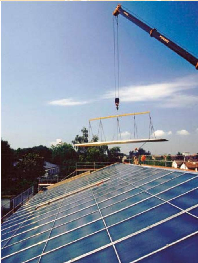
■ Senkung der Montagekosten - Große Flächen können schnell und sicher mithilfe des Autokrans montiert werden. Bild: Wagner & Co. Solartechnik
