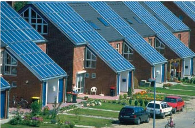
■ 3000 m<sup>2</sup> Sonnenkollektoren liefern Wärme für über 100 Reihenhäuser in der solaren Nahwärmeversorgung Hamburg-Bramfeld.
