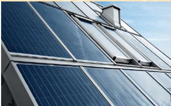
■ Vom Schutzdach zum Nutzdach - Neben Solarthermie lassen sich auch Photovoltaik und Dachfenster mit einem System vollflächig integrieren.
