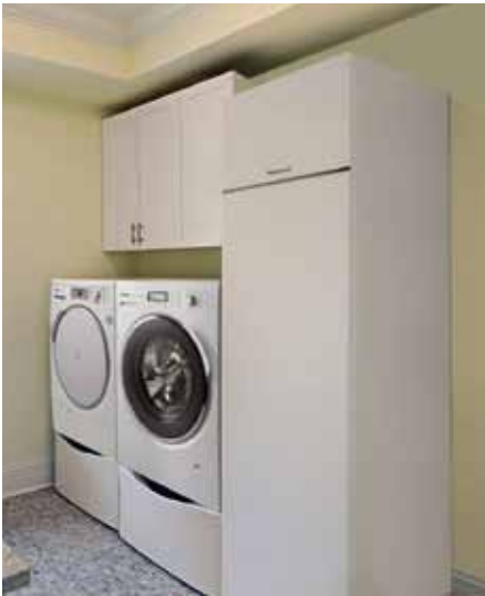
Kompakt-Wärmepumpen benötigen nicht zwingend einen Heizraum und können im Haus zum Beispiel in einem Hauswirtschaftsraum aufgestellt werden. Bild: Panasonic
