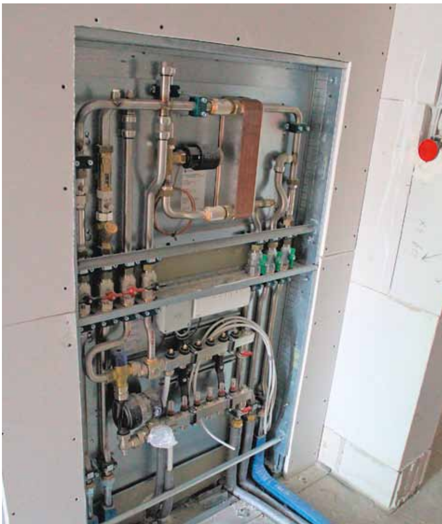
Wohnungsübergabestationen übernehmen als kompakte Installationseinheiten die geregelte Wärmeverteilung sowie die Durchfluss-Trinkwassererwärmung. Bild: Wolfgang Heinel
