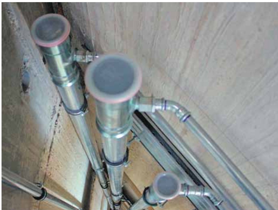
Beim Einsatz von Wohnungsstationen verlaufen im Installationsschacht nur noch drei Leitungen für Heizung Vorlauf/Rücklauf und Trinkwasser kalt. Für bivalente Heizsysteme mit Hoch- und Nieder-temperaturkreisen sind auch Wohnungsstationen für die Einbindung in 4-Leiter-Systeme verfügbar.
