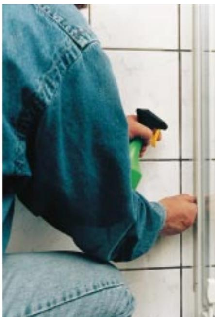
**Bild 12:** Die Silikonnaht wird sofort geglättet, zum Beispiel durch Aufsprühen von Spülmittel und anschließendem Abziehen mit dem Daumnagel oder einem Silikonspachtel.
