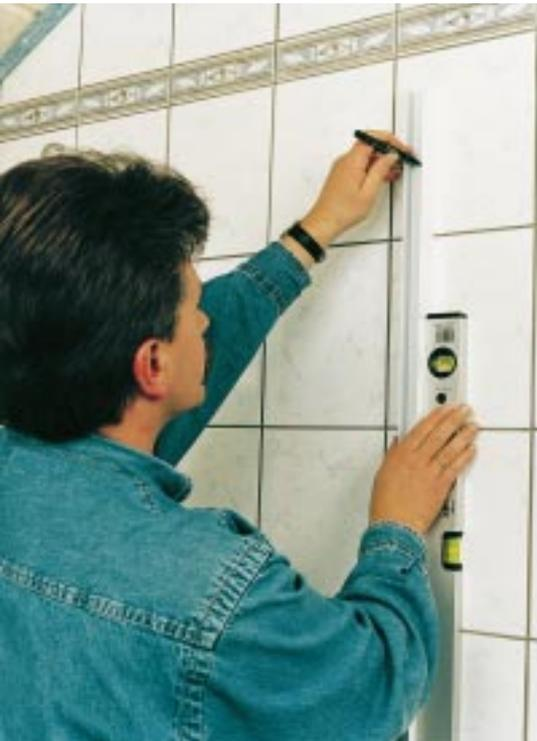
**Bild 4:** Ein wichtiges Werkzeug beim Aufstellen einer Duschkabine: Die Wasserwaage.
