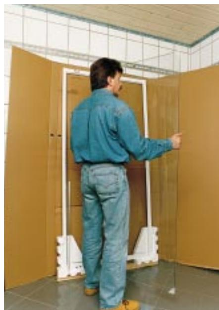
**Bild 2:** Besondere Sorgfalt beim Auspacken gilt den ungerahmten Glasscheiben aus Einscheiben-Sicherheitsglas.
