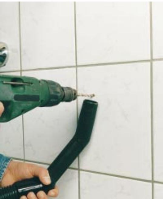
**Bild 5:** Mit dem Staubsauger werden Verschmutzungen durch Bohrstaub problemlos vermieden.
