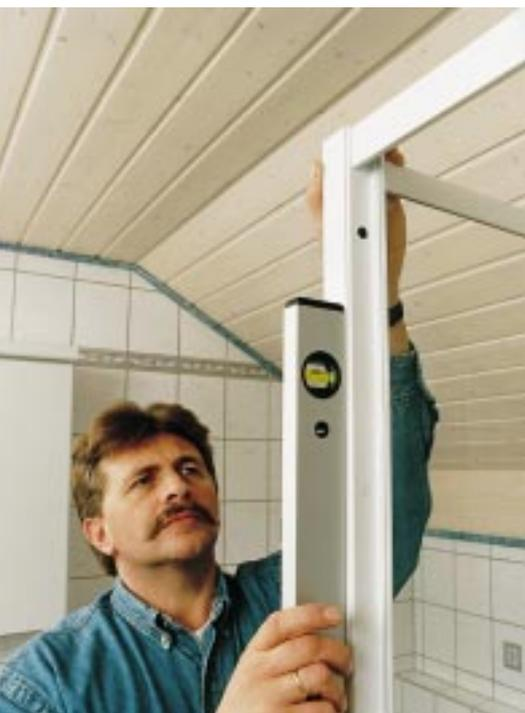
**Bild 9:** Ein im Lot ausgerichteter Türrahmen ermöglicht später einen exakten Türschluß.
