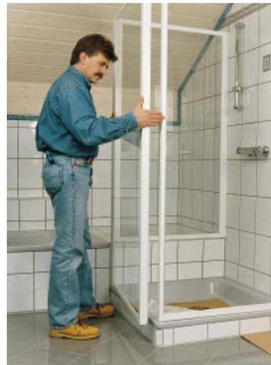
**Bild 8:** Beim Zusammenbau können Seitenwand und Tür leicht nach außen gedrückt werden, um die Profile ineinander zu schieben.
