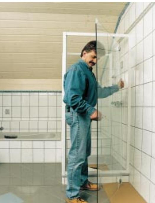
**Bild 10:** Nach dem Verschrauben der Kabine wird der Türflügel eingesetzt.
