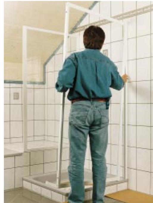
**Bilder 6 und 7:** Durch leichtes Kippen im oberen Bereich lassen sich Seitenwand und Türrahmen in den Wandanschluß einschieben.
