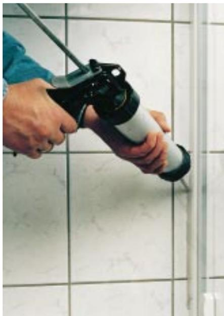
**Bild 11:** Die richtige Versiegelung mit Silikon schafft optimale Dichtheit.
