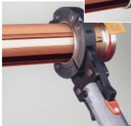
**Bild 10:** Markierung der Einstecktiefe beachten und Preßvorgang starten. Der Ablauf erfolgt vollautomatisch.
