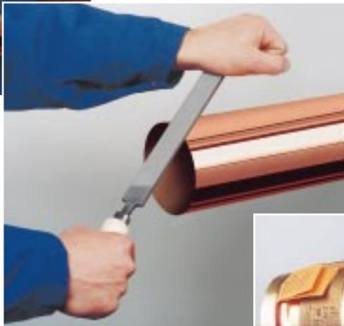
**Bild 2:** Rohr außen und innen sauber entgraten. Dazu Rohrende mindestens 100 mm aus dem Schraubstock herausspannen (gilt für alle Dimensionen).
