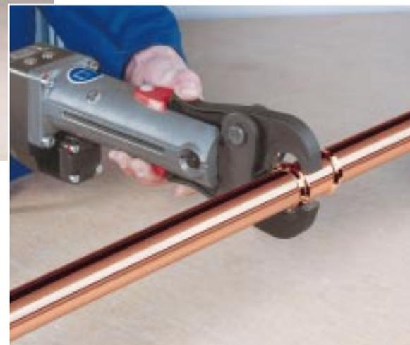
**Bild 9:** Nach der Verpressung: Die Preßbacke öffnen.
