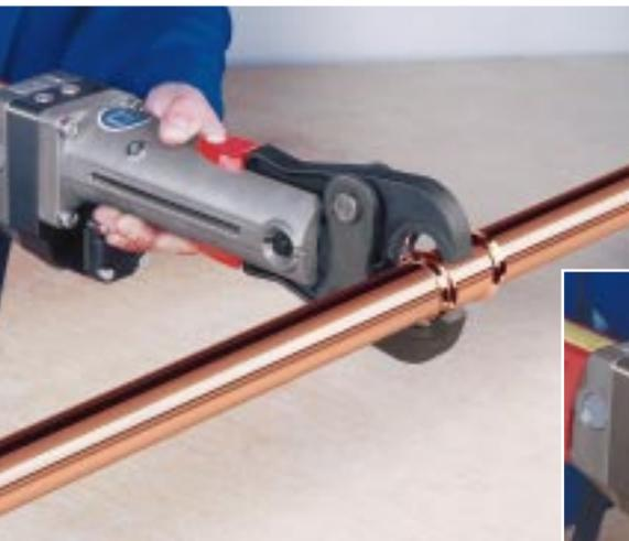
**Bild 7:** Preßbacke öffnen und rechtwinklig auf den Verbinder setzen.
