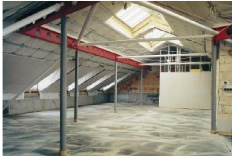
**Bild 3:** Außer Absanden benötigt Gußasphalt keine weitere Nachbearbeitung. Bereits nach ca. 2 Stunden kann der Baubetrieb fortgesetzt werden.
