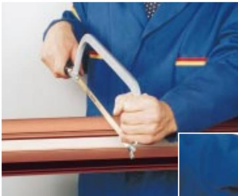
**Bild 1:** Kupferrohr rechtwinklig mit feinzahziger Stahlsäge ablängen.
