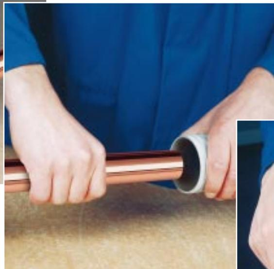
**Bild 2:** Rohr außen und innen sauber entgraten.
