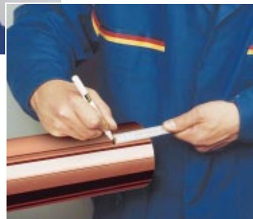
**Bild 4:** Einstecktiefe auf dem Rohr markieren.
