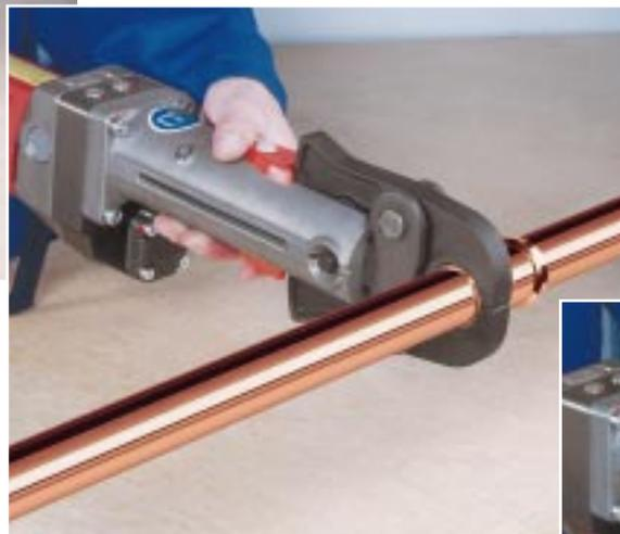
**Bild 8:** Preßvorgang starten. Die doppelte Verpressung (vor und hinter der Sicke) in einem Arbeitsgang erfolgt vollautomatisch.
