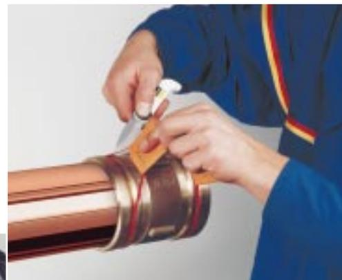
**Bild 11:** Preßbacke öffnen, Preßkette abnehmen und Kontrollring entfernen.
