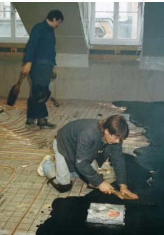
**Bild 2:** Die Einbringung des Gußasphalt-Estrichs erfolgt in zwei Schichten. Die erste, die bis auf Höhe des Rohrscheitels eingebracht wird, fixiert die Kupferrohre auf der Unterlage.
