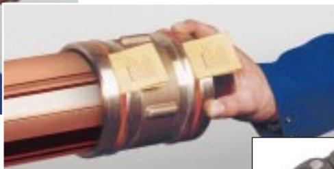
**Bild 6:** Preßfitting (Preßverbinder) und Rohr bis zur markierten Einstecktiefe gerade ineinander schieben. Verkantungen sind zu vermeiden.
