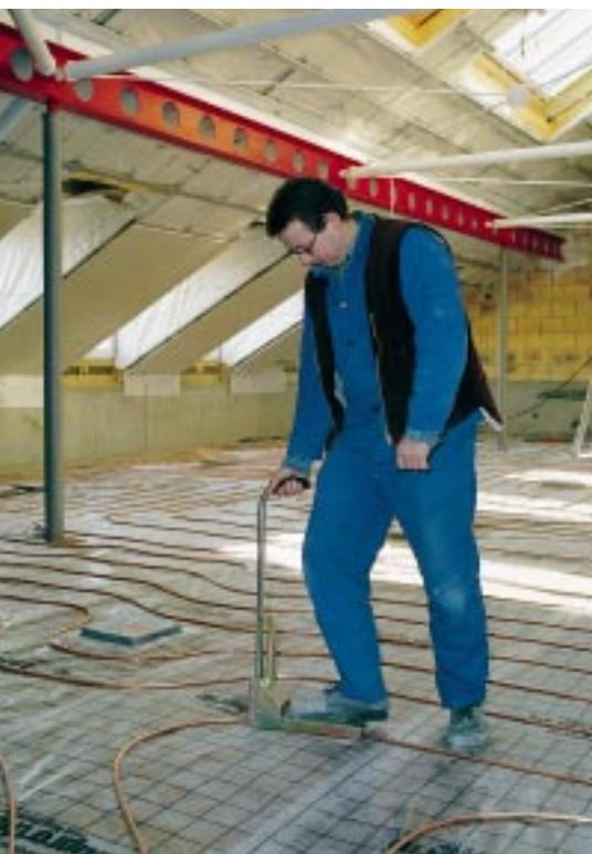
**Bild 1:** Der Verlauf der Heizungsrohre aus Kupfer kann frei gewählt und Säulen, Bodenauslässe für Elektrik ohne weiteres ausgespart werden. Zur Befestigung nahmen die Monteure das Setzgerät zu Hilfe.
