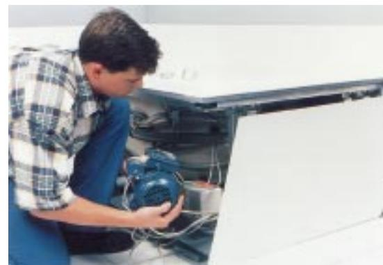
Mit dem „Varitop-open“ lassen sich Reparaturen und Wartungsarbeiten an Whirlwannen problemlos durchführen.
