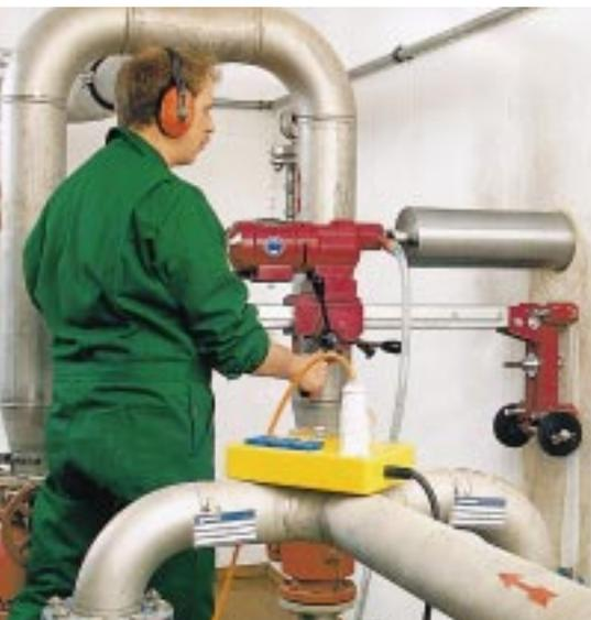
Bild 2: Ein Diamant-Bohrsystem im Einsatz.
