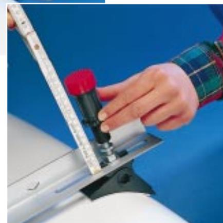
▲ **Wannenaufgabe der Wannenvölbung anpassen, so daß die Auflage vollflächig aufliegt. Dazu ist die Wannenaufgabe dreh- und schwenkbar. Kontermutter fest anziehen.**
