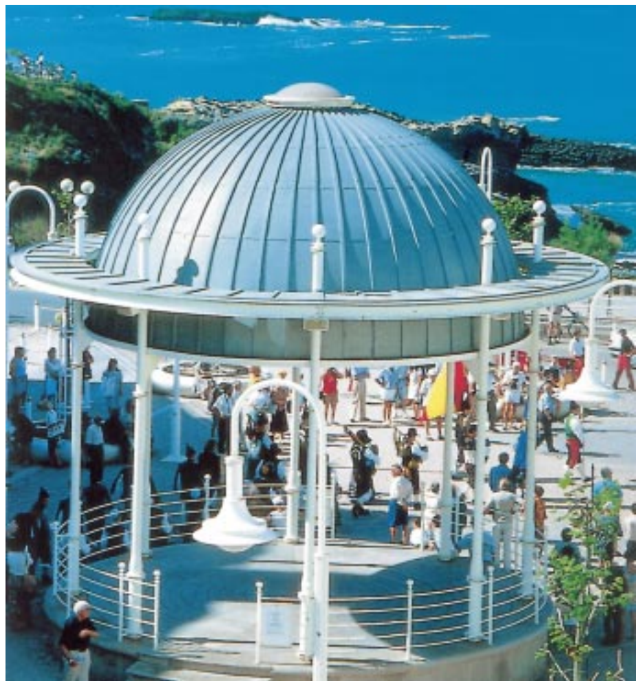
Bild 4: Detail einer meisterlich ausgeführten Metallbedachung. In vielen Einzelheiten wird das Können des ausführenden Handwerkers sichtbar.
