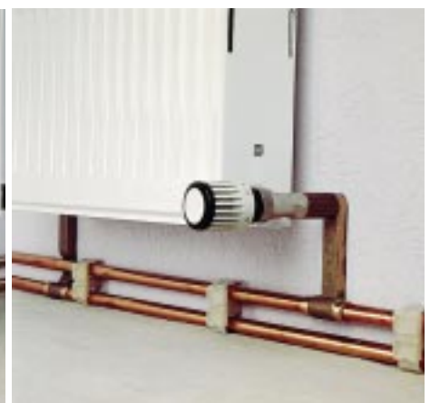
Bild 9: Heizkörperanschluß mit Lötanschlüssen, für Heizkörper mit seitlichen Anschlüssen unten.
