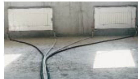
Bogenförmig verlegte Rohre erschweren dem Estrichleger das Zuschneiden der Dämmplatten.
