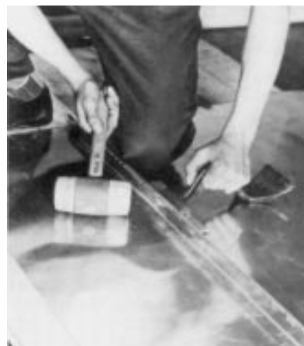
Bild 2: Die Doppelstehfalztechnik kommt aus der Tradition des Handwerks und wurde im Laufe der Zeit modernisiert. Neben manuellen Arbeiten an Anschlüssen und Übergängen steht heute der Einsatz moderner maschineller Profilier- und Falzgeräte. Im Bild sind Falzarbeiten an einem Modell zu sehen.
