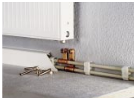
Bild 8: Heizkörperanschluß (zweiteilig) mit Klemmringverschraubungen, für Fertigheizkörper.
