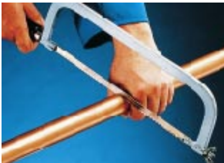
Bild 1: Copatin-Rohr rechtwinklig abblängen.
