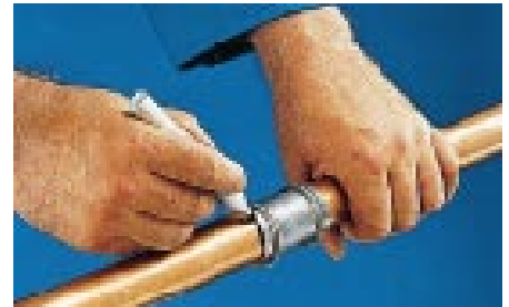
Bild 5: Einstecktiefe markieren.
