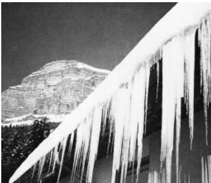
Bild 1: Schneereiche Gebiete mit strengen winterlichen Bedingungen machen elektrische Dachrinnen- und Regenfallrohrbeheizungen erforderlich. Der Bauherr erhält dadurch zusätzliche Sicherheit gegen Schnee-, Eis- und Schmelzwasserschäden an wertvoller Bausubstanz.
