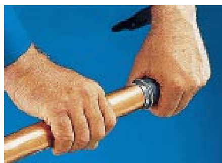
Bild 4: Fitting, beziehungsweise Rohr, unter leichtem Drehen auf- beziehungsweise einschieben.
