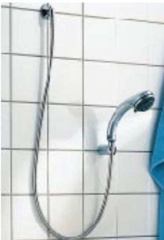
Der neue Brauseschlauch-Anschlußbogen ist mit zwei Rückflußverhinderern ausgestattet.
