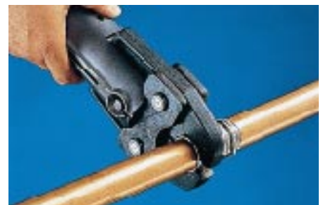
Bild 6: Preßbacke öffnen, winklig auf die Sicke des Preßfittings aufsetzen und Preßvorgang auslösen.
