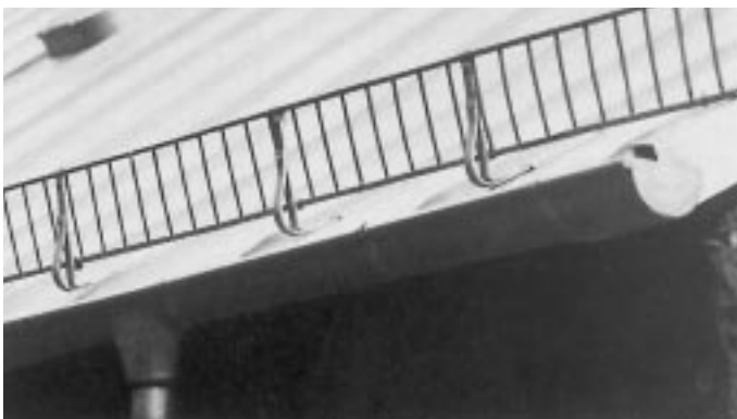
Bild 3: Teilansicht eines Schneefanggitters, unmittelbar oberhalb der Traufe. Befestigung mittels Haltebügeln aus „Flachmaterial“ (ähnlich wie Leiterhaken).
