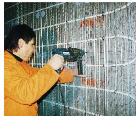
**Bild 3: Einfache Befestigung der Streckmetallbahnen mittels Tellerdübel.**
