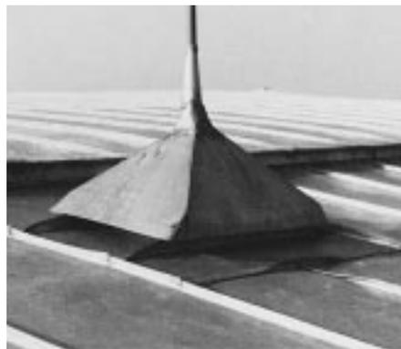
**Bild 5:** Tragseildurchführung im Doppelstehfalzdach.
