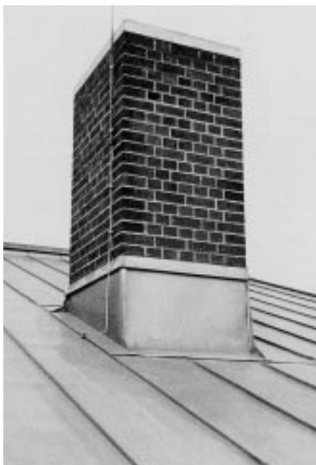
**Bild 1:** Bauteile wie dieser Schornsteinkopf, die die Metalldachhaut durchdringen, müssen handwerksgerecht eingefast werden. In der Regel werden, wie hier, Falzanschlüsse hergestellt und mit einer Kappleiste (Überhang) verwahrt.
