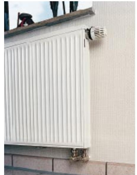
Nach b: Bei diesem Ventilheizkörper treten die Anschlußleitungen in Höhe der Anschlußverschraubungen aus der Wand.
