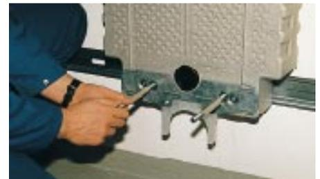
**Bild 3:** Element und Deckblech an der Schiene befestigen. WC-Bolzen einschrauben.
