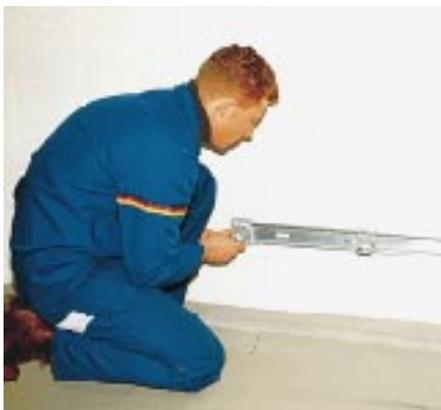
**Bild 1:** Befestigungshöhe und Mittelachse anzeichnen. Wandschiene waagrecht und mittig ausrichten, anbohren und festschrauben. Schienenadapter in die Schiene einsetzen.
