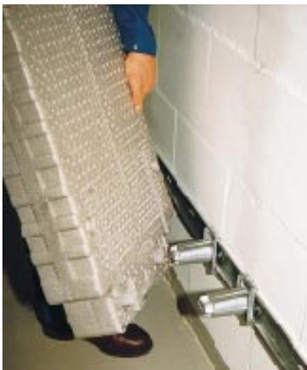
**Bild 2:** Element auf die Schienenadapter aufstecken.
