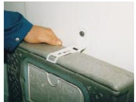
**Bild 4:** Obere Befestigungsflasche am Element anbringen und festdübeln.
