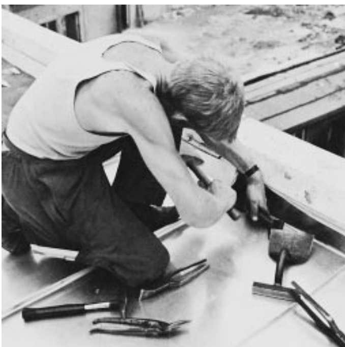
Bild 1: Herstellen des Wandanschlusses beim Doppelstehfalzdach; die handwerkliche Ausführung erfordert geschickte Hände und fachgerechtes Werkzeug.
