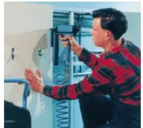
Bild 7: Mit dem neuen „Speedtacker“-Verfahren werden die Verkleidungsplatten in Windeseile befestigt.
