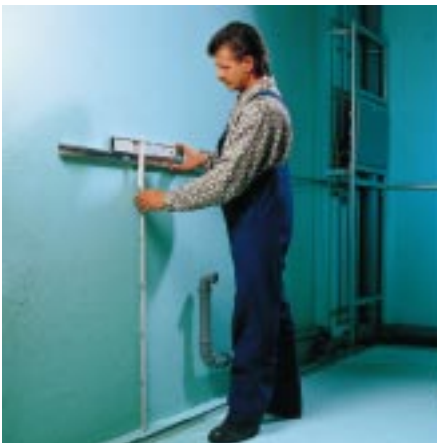
Bild 1: Ausrichtung und Befestigung der Wandschiene.
