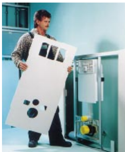
Bild 6: Die vorgestanzten Fermacellplatten sind mit Durchbrüchen für die meisten Anschlüsse versehen.
