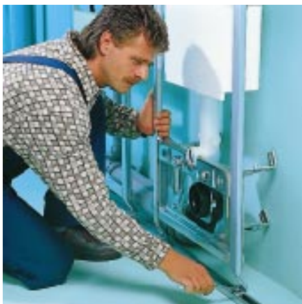
Bild 4: Einsetzen und Arretierung der Montageelemente mit dem „Klick“-Schnellverschluß.
