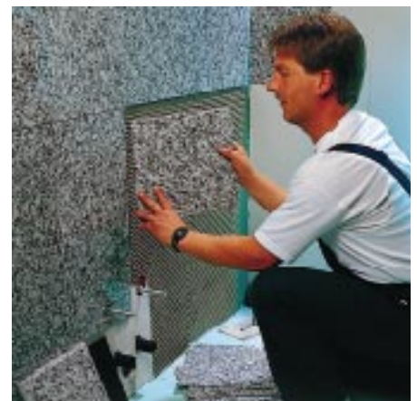
Bild 8: Einfach aufgeklebt werden die Fliesen.
