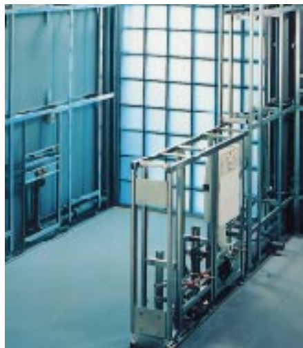
Bild 5: In den Zwischenräumen der Wand bzw. Raumteiler-elementen werden die erforderlichen Rohrleitungen verlegt.
