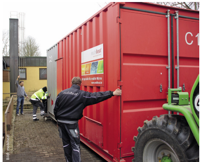
Autark und fernüberwacht: die mobile Heizanlage von mobiheat, bestehend aus Heizzentrale mit 1 MW Leistung und doppelwandigem Heizöltank (4800 l). Der Heizcontainer, angeliefert mit dem mobiheat-eigenen Lkw mit Kran, übernahm vorübergehend die Beheizung des Hallenbades Almarin in Mönchsdeggingen (westlich von Ingolstadt).
