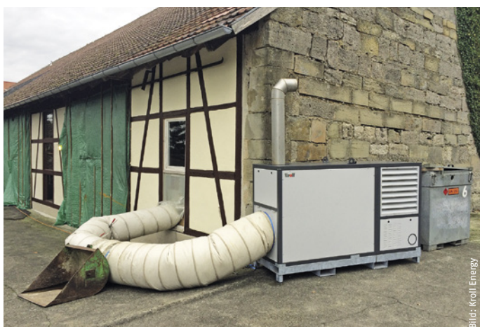
Bei der Baubeheizung wird gern auf mobile Heizzentralen zurückgegriffen. Hier das Modell „HM100“ (Kroll) im Einsatz.
