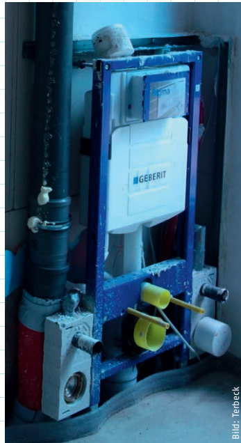
Bild 1: Unterputzspülkasten noch während der Rohbauphase.
