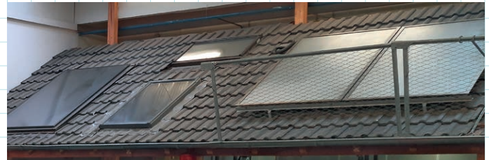
Bild 3: Indach- (links) und Aufdachmontage (rechts).
