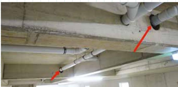
Die Bohrungen befinden sich im Feld und nicht an den Auflagern. Zudem auf halber Trägerhöhe. Also alles ok? Doch wenn man genau hinsieht, erkennt man den Fehler: Beim rechten Rohr hat jemand wohl nicht richtig gemessen: Man musste zweimal ansetzen, um das Rohr hindurchzubringen. Dadurch wird unnötig wichtiges Material entfernt, welches eigentlich zur Tragfähigkeit des Trägers erforderlich ist. Daraus lässt sich die 3. Regel ableiten:
