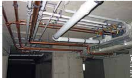
Bild 1: Situation in der Tiefgarage.
