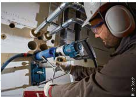
Diamantbohrsystem in Aktion.
