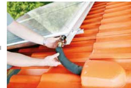
Das wärmegeämmte Solarrohr wird aus dem Dachstock durch die Solar- oder Lüftungsziegel nach außen geführt. Ein flexibles Rohr erleichtert den Anschluss der Leitung an die Kollektoren deutlich.
