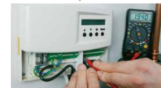
Die Regelung ist das Gehirn der gesamten Anlage. Hier prüft der Handwerker, ob der Temperaturfühler auf dem Dach auch richtig angesteuert wird. Die Solarregelung koordiniert den Transport der Wärme aus den Kollektoren in den Speicher.
