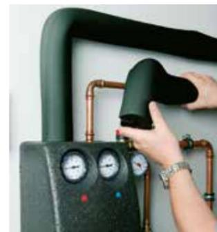
Auch im Heizungskeller sollten die wärmeleitenden Leitungen isoliert werden. Korrekt installierte Wärmedämmungen machen einen guten Eindruck beim Kunden und geben der Anlage im Heizungskeller den letzten Schliff.
