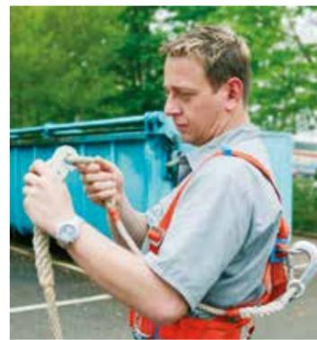
**Los geht's:** Doch vorher steht die Sicherheit. Wie bei allen Arbeiten auf dem Dach oder auf Baugerüsten müssen Handwerker richtig gesichert sein. Verfügt das Gerüst nicht über Absturzsicherungen, so ist das Tragen eines Absturzgurtes mitsamt Seilsicherung ein absolutes Muss.
