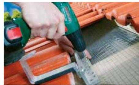
Anhand der Sparrenbreite und der mitgelieferten Schablone für die Sparrenanker lassen sich die Montagepunkte auf dem Dach bestimmen. Die Dachpfannen müssen dort, wo die Sparrenanker sitzen müssen, zur Montage entfernt werden. Dann werden die Anker an den Sparren geschraubt und horizontal auf die Ziegelform angepasst.
