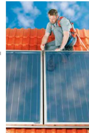
Beim Verbinden der einzelnen Kollektoren ist darauf zu achten, dass die beiden Anschlussstücke ohne großen Kraftaufwand miteinander verschraubt werden können. Die mechanische Belastung muss beim Betrieb der Anlage so gering wie möglich sein. **Hinweis:** Liegen die Kollektoren nicht parallel nebeneinander, sollte die Unterkonstruktion überprüft werden.
