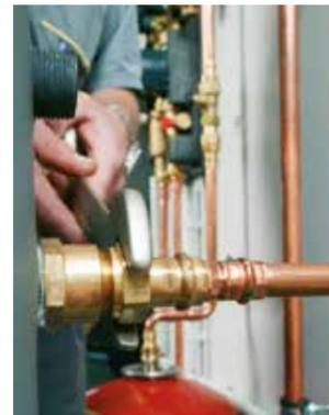
**Achtung:** Vor- und Rücklauf an die richtigen Stützen anschließen, vergleiche Montageanleitung des Speichers.
