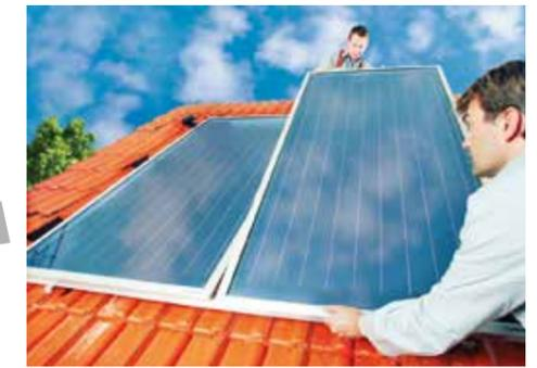
Zu zweit ist das Einhängen der pro Stück rund 50 Kilogramm schweren Kollektoren kein Problem. Die Montageanleitung gibt hier die wichtigsten Tipps. Die Kollektorfläche des hier abgebildeten Junkers-Kollektors FK 210 beträgt 2,1 m<sup>2</sup>.
