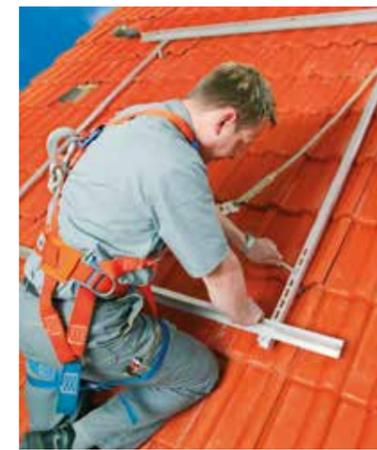
Auf die Sparrenanker kommt der Montagegerahmen – in der Regel aus witterungsbeständigem Aluminium.
