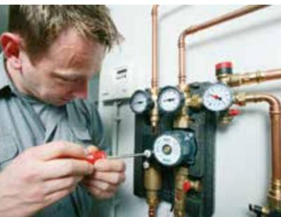
An der Solarstation ist Fingerspitzengefühl gefragt. Über ein Regelventil muss der Installateur die Durchflussmenge einstellen. Die Montageanleitung gibt den Nenndurchfluss an. Als Richtwert: 35 bis 45 l pro m<sup>2</sup> Kollektorfläche und Stunde.
