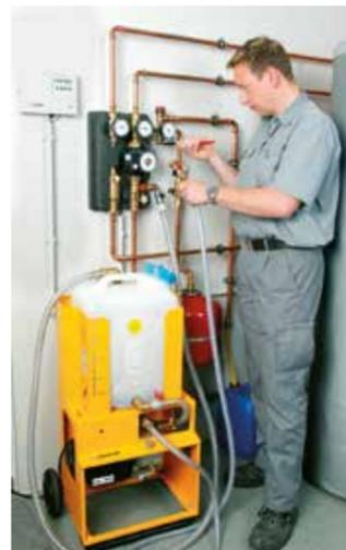
**Hinweis:** Wenn die Sole selbst gemischt wird, sollte zur Sicherheit vor Befüllen der Anlage der Frostschutz der Solarflüssigkeit geprüft werden. Bei der vom Hersteller bereitgestellten Sole ist dies nicht notwendig.
