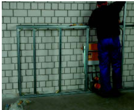
Das WC-Modul wird an der entsprechenden Stelle eingesetzt.
