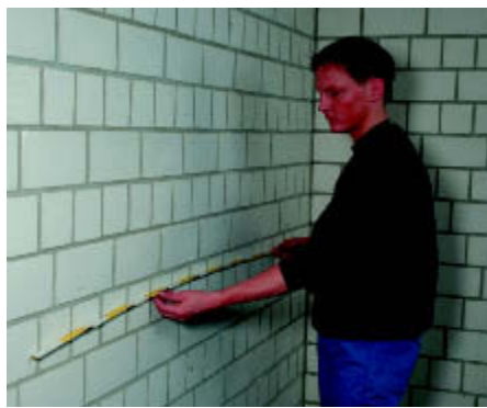
Die Maße (Breite, Höhe, Tiefe) der Vorwand werden bestimmt, sofern sie nicht schon durch den Architekten, Planer oder Bauherren im Vorfeld festgelegt wurden.
