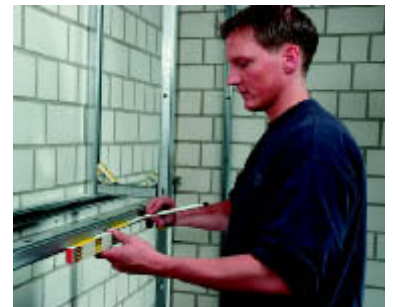
Der richtige Abstand aller senkrechten Schienen zueinander wird angezeichnet, damit die Module später genau eingesetzt werden können.
