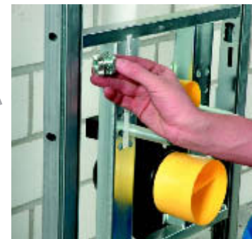
Mit den beiliegenden Nutensteinen werden die Module an der offenen Schienenseite positioniert und festgeschraubt.
