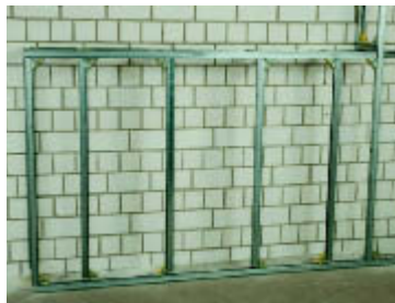
Das „Steptec-Gerüst“ ist nun fertig gestellt, lediglich die verschiedenen Module fehlen noch.
