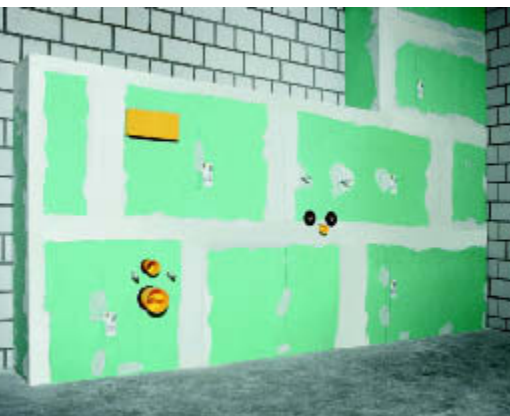
Fertig! Die gesamte Vorwandkonstruktion ist mit GKF-Platten verkleidet. Jetzt kann der Fliesenleger seine Arbeit beginnen. Zum Schluss werden dann die verschiedenen Keramiken wie WC oder Waschtisch angebracht.
