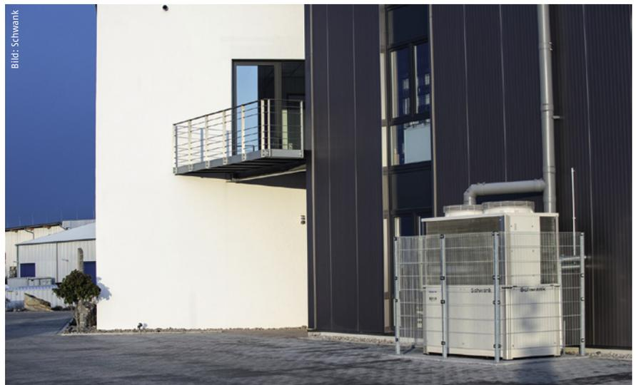
Die Gaswärmepumpe wurde unauffällig hinter dem Gebäude installiert. Da die Mitarbeiterparkplätze direkt daneben liegen, wurde ein Schutzgitter außen herum angebracht.
