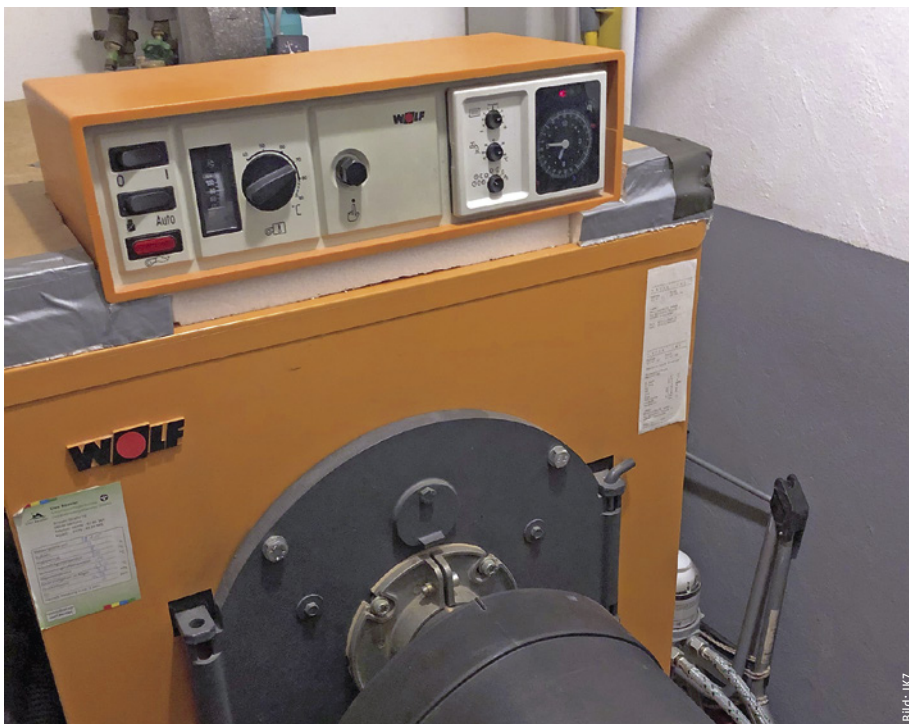
Der in dem Beispiel aufgeführte Öl-Heizkessel-Oldtimer mit untergebaubtem Warmwasserspeicher hat eine Leistung von 27 kW. Laut verbrauchsbasierter Berechnung wäre der neue Kessel mit 15 kW Leistung ausreichend bemessen.
