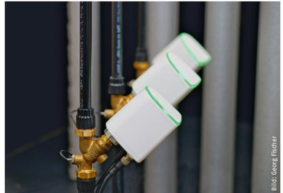
In die Ventile eingebaute Sensoren für Temperatur und Druck liefern für die Temperaturüberwachung die nötigen Messwerte.
