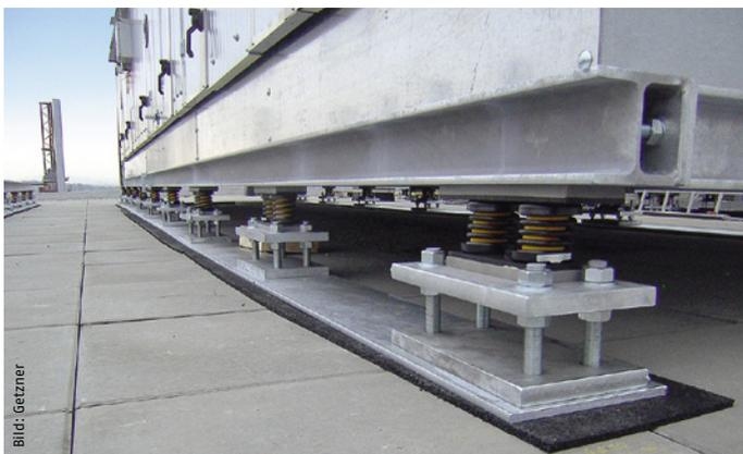
Lagerung einer RLT-Anlage auf Stahlfedern mit integriertem Dämpfungskern „Isotop DSD-BL“.
